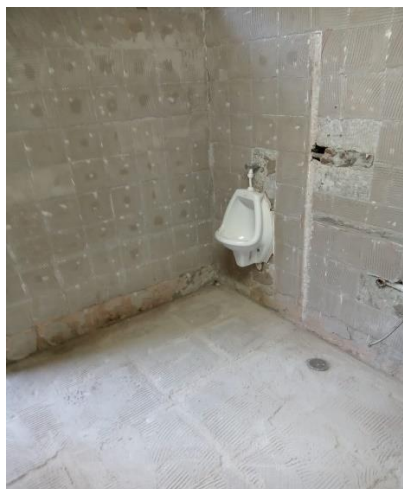
Figura 26: Reforma dos vestiários e sanitários.
