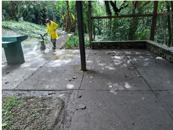
Figura 23: Lavagem dos pisos e caminhos com lavadora de alta pressão.
