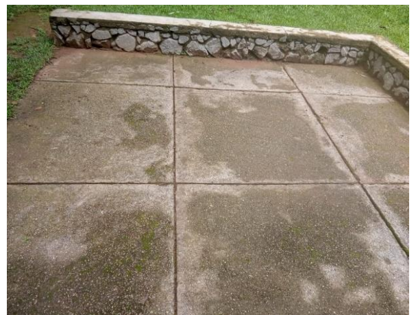
Figura 9: Despraguejado do piso.
